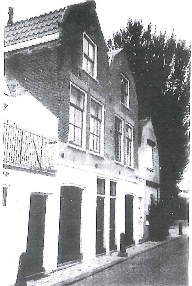
Vest 158 - 160 na de restauratie.
