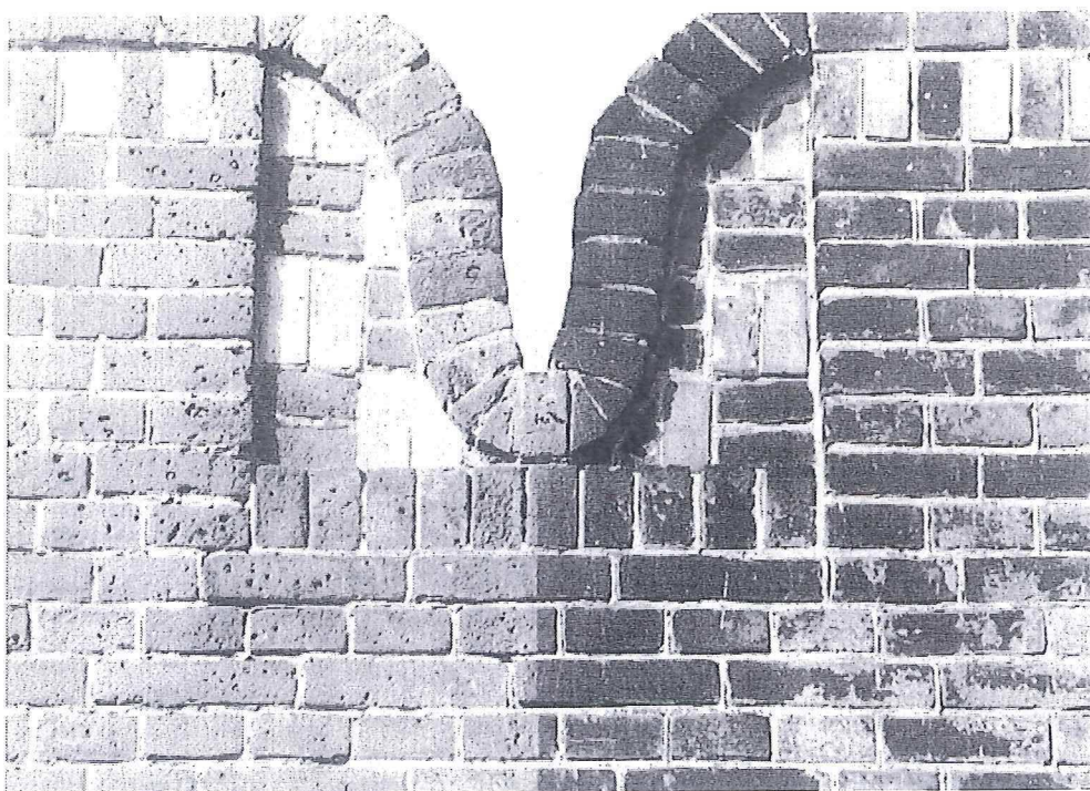
Gevolgen van het stralen van de gevel: de linkerhelft is gestraald, de rechterhelft is niet behandeld.
