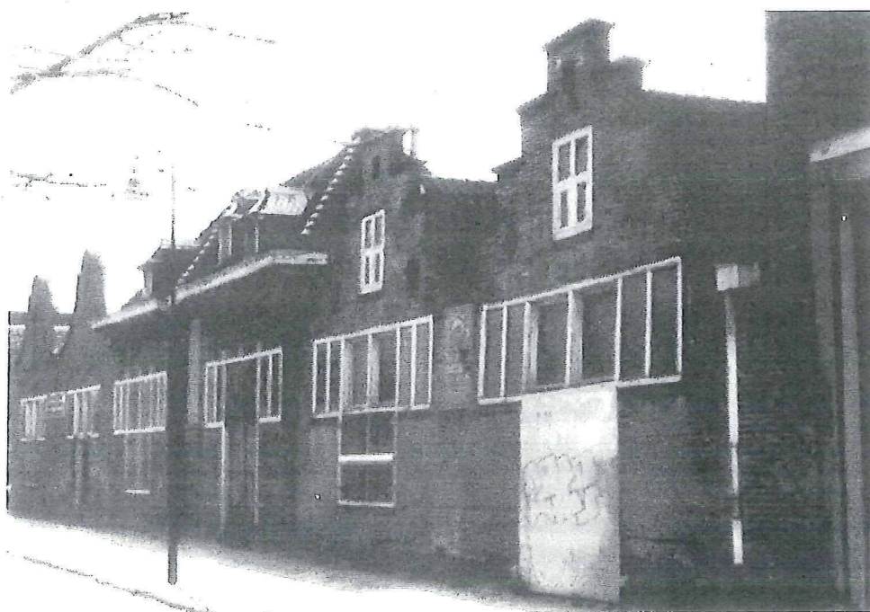
Raam 28-32, panden van de voormalige plateefabriek Zuid-Holland.
