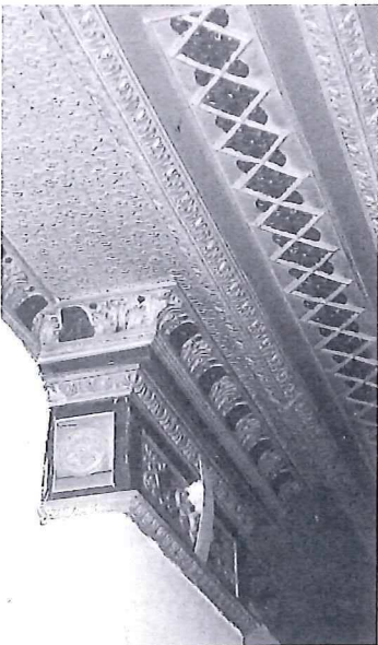
Plafond Hoge Gouwe 73; helaas zijn op deze afbeelding de fraaie kleuren niet zichtbaar.
