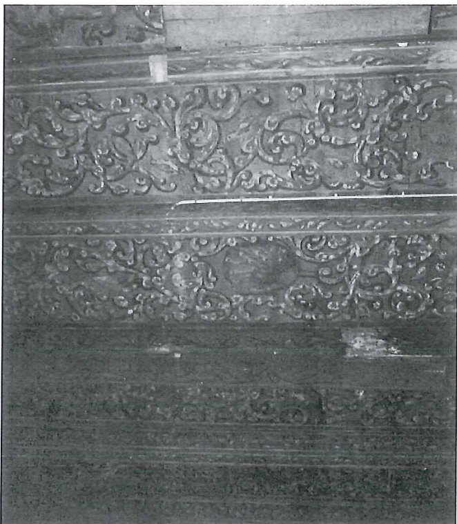
Het plafond in Westhaven 65 werd in 1630 door Anthony Hendricks beschilderd
