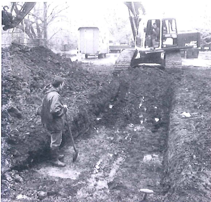
De heer Ton Prinsen (Golda) begeleidt het aanleggen van de proefsleuf.
