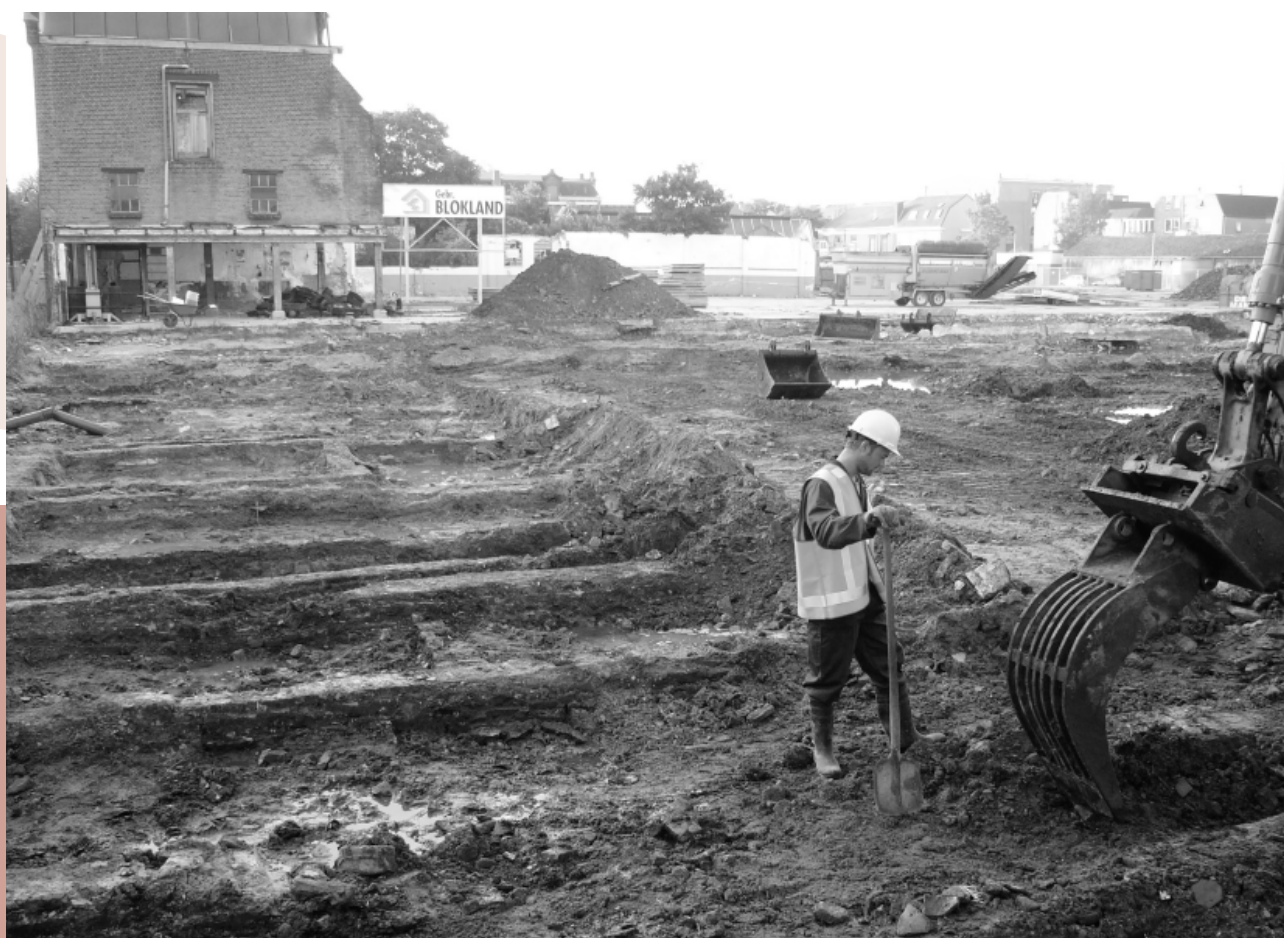
Het voorzichtig vrijleggen van de funderingen. (foto ARC BV)
