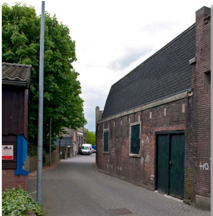
Achterzijde van het pand aan de Houtenstraat 19, gezien vanaf de Vest.
