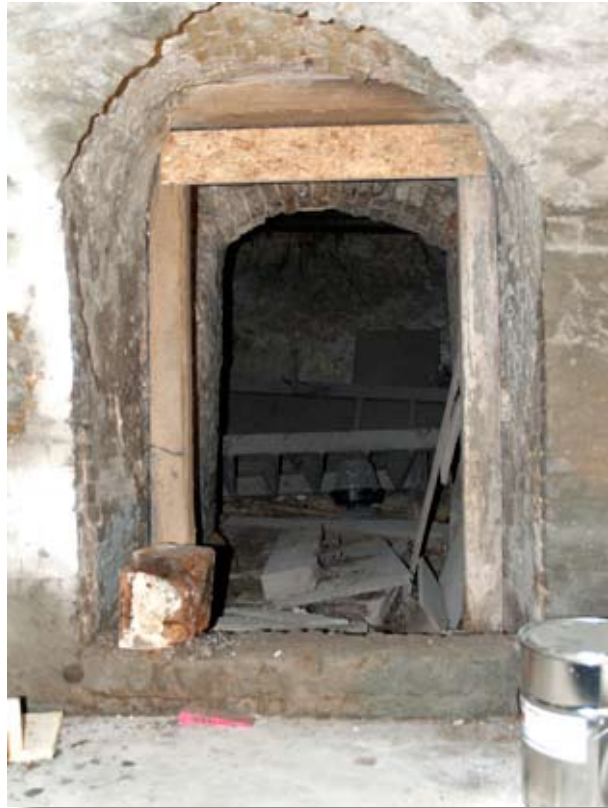
Kelderingang in de onderdoorgang Dubbele Buurt onder één van de bovenliggende panden.
