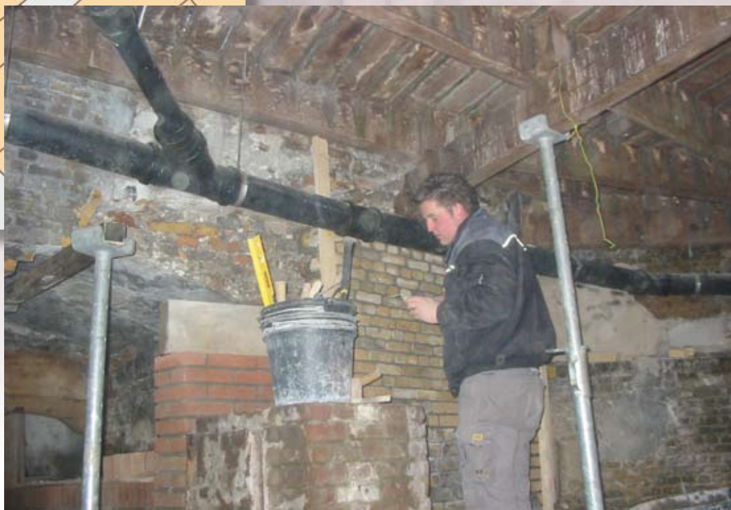
Metselaar bezig met het herstellen van de voormalige kelderingang van de Wijdstraat. Deze kelder is verdwenen met de bouw van Magazijn de Zon
