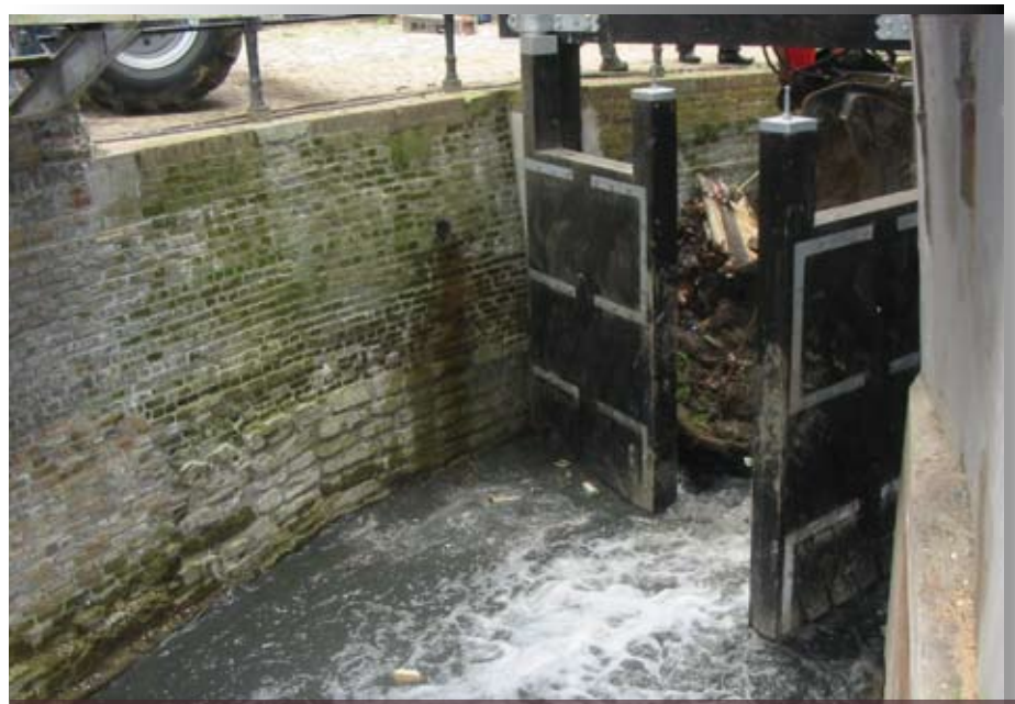
Na de restauratie werd de dam weggehaald en stroomde het water via het sluisje weer de overkluizing in
