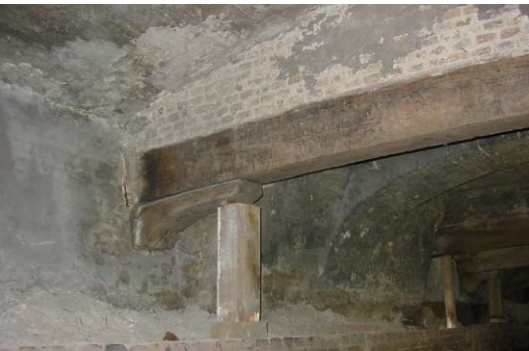
Bijzonder is de grote overspanning en het feit dat de ruimte boven de balken is opgevuld met Ijsselsteentjes
