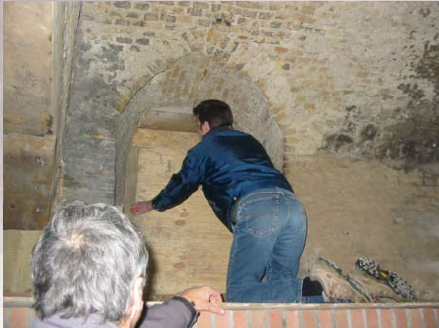
Onder een van de panden aan de Dubbele Buurt is de kelderingang nog aanwezig. Tijdens de restauratie was hij tijdelijk afgesloten
