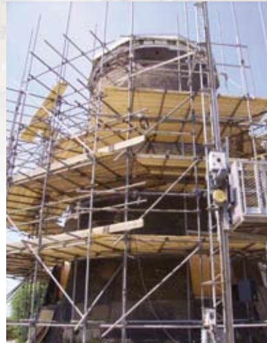
Molenkap waarop later het riet geplaatst is
