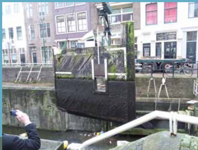
Sluisdeuren worden vervangen
