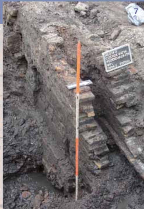
Diverse funderingen die op elkaar zijn gezet. De onderste laag dateert uit ongeveer 1450, de bovenste laag rond 1750.
