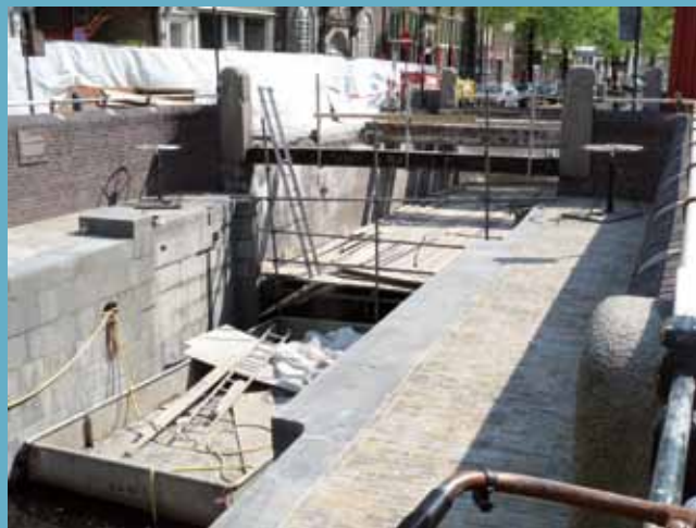
Restauratie van de sluis en de brug
