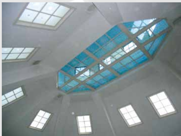
De gerestaureerde lichtkoepel
