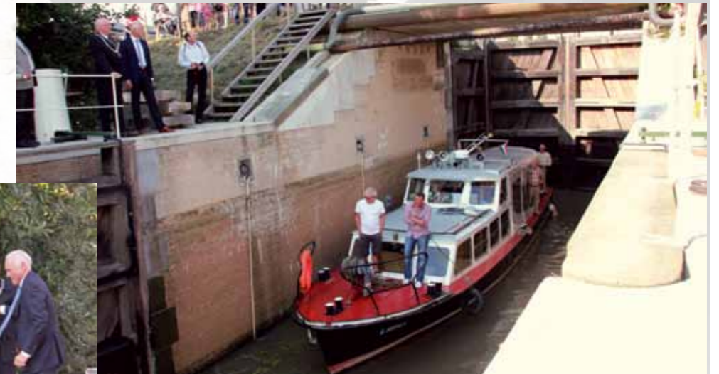
De eerste boot vaart door de gerestaureerde sluis
