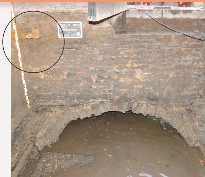
Spaarboog in de westfundering van de Vrouwetoren. Linksboven is het verroeste ophangstelsel van de oorspronkelijke deur van de toren zichtbaar, rechtsboven de huidige deur.
