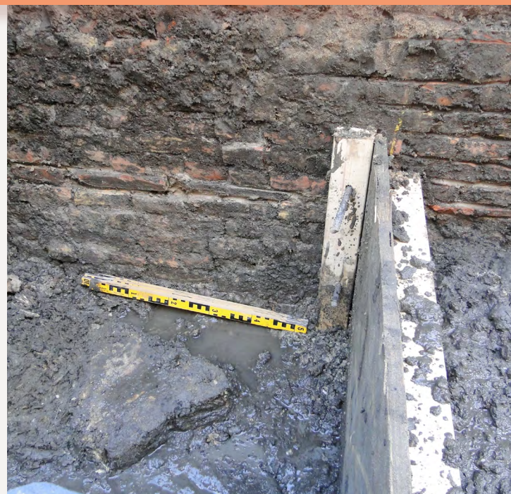
Laag dakpannen/vloertegels die in 1493 is gebruikt om de fundering (toen nog in aanbouw) op één niveau te brengen (6 e laag van onder). Links is de laag bijna net zo dik als een normale baksteenlaag, rechts (net buiten de houten damwand) meet hij nog slechts 1 cm.
