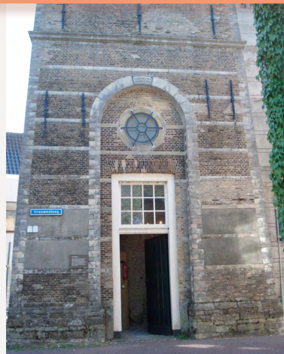
De in 1754 verplaatste deur in de verbrede westgevel van de toren
