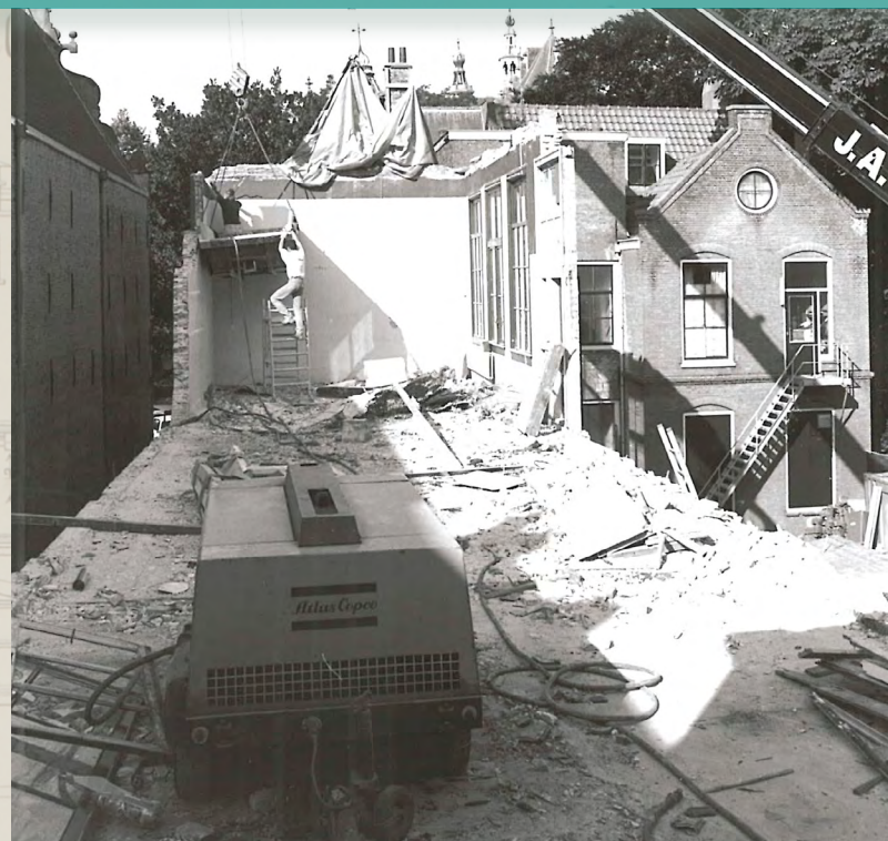
De sloop van de zijvleugel aan de Patersteeg 1 van de voormalige Klaas de Vriesschool wegens nieuwbouw t.b.v. de Streekarchiefdienst Hollands Midden, 1993
