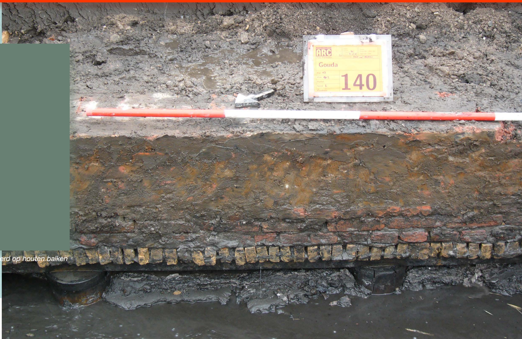
Houten paalkoppen boven het waterpeil
