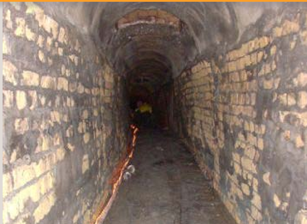
Gemetselde zijkamer onder en nabij de Gouwekerk
