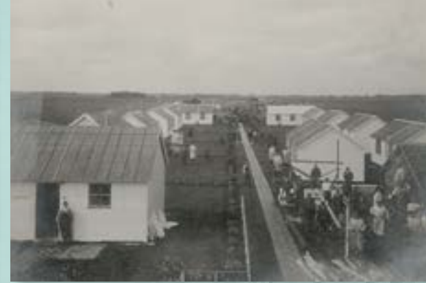
Demontabele woningen. Later worden ze naar België overgebracht waar een tekort aan woningen is.
