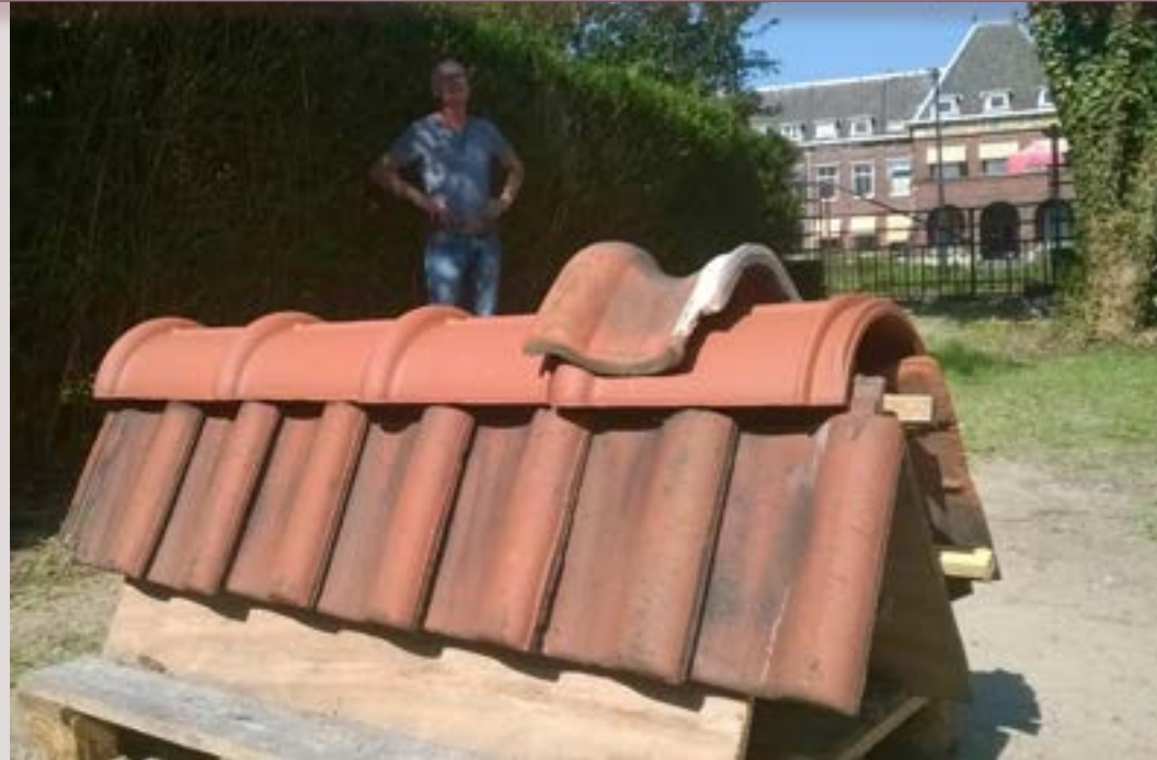
Proefopstelling pannendak met standaard nokvorsten en de originele zadelforst hier bovenop
