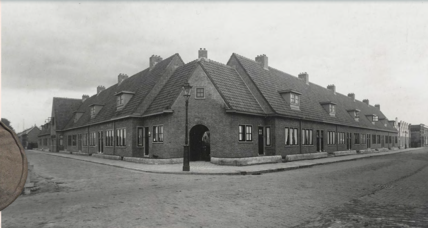
Hofje met bejaardenwoningen op de hoek Derde Kade en Noothoven van Goorstraat
