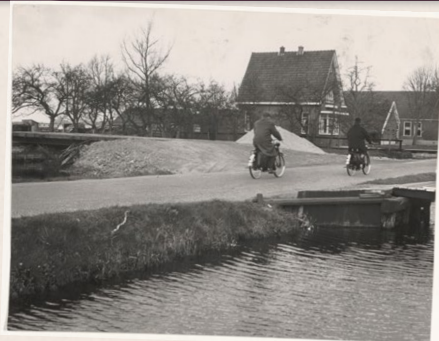
Bouwrijp maken door dempen sloot Bloemendaalseweg ter hoogte van witlofkeukerij (foto Goudsche Courant 1967)
